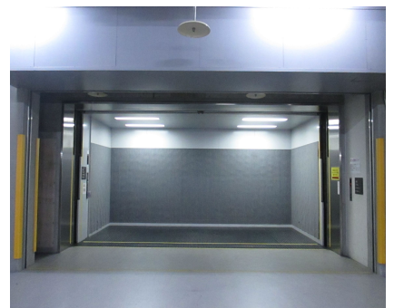
搬入EV開口
